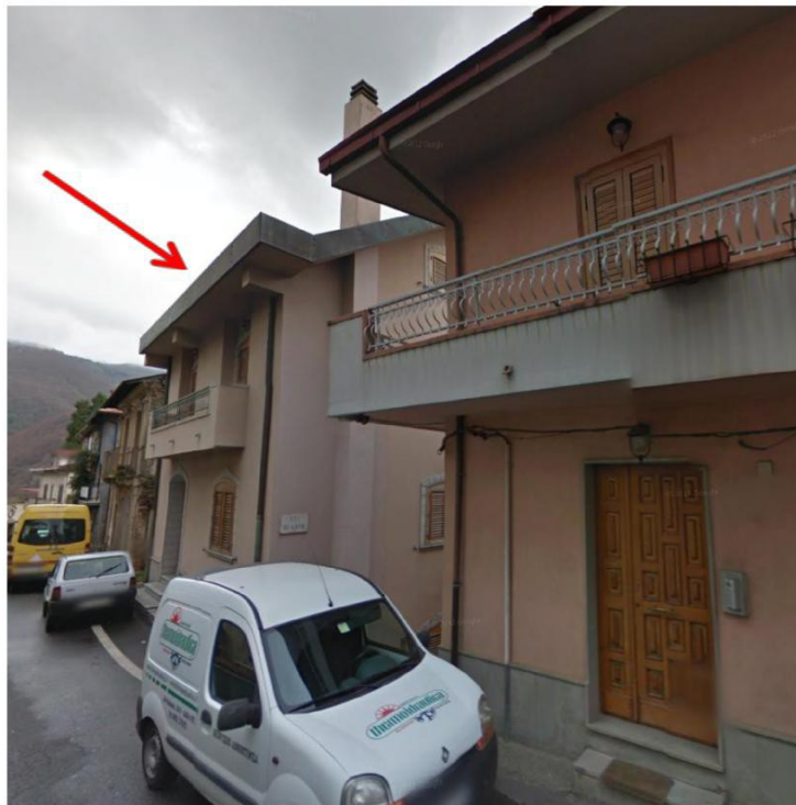
Foto n. 3 : Vista dell'immobile dall'angolo di Via Quarto
